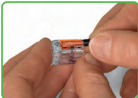
Odizolujte vodič v délce 11 mm.
