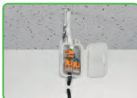
Závěsné připojení světel ze stropních podhledů
